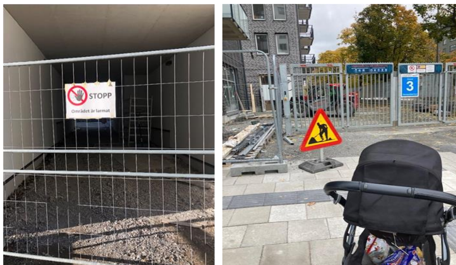
Figur 20. Svårt att ta sig fram under byggnationer (författarnas fotografier)
