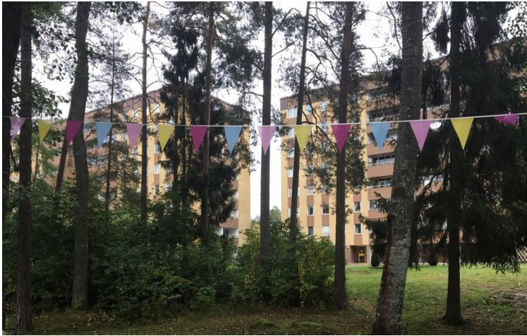
Figur X En rymligare och grönnare miljö i Gottsunda, byggd på 1960–70-talet. Hustypen [skivhus] är placerade parallellt, och här fristående och något indragna bakom byggnaden framför.
