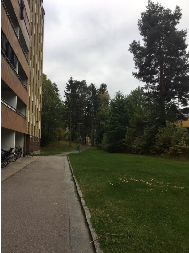
Husfasad på Stenhammarsväg med gångväg och utsikt mot bostadsgårdarna.
