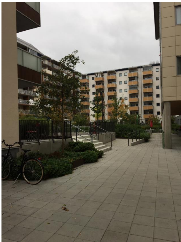
Utsikt från gatan in mot en bostadsgård i Kungsängen.
