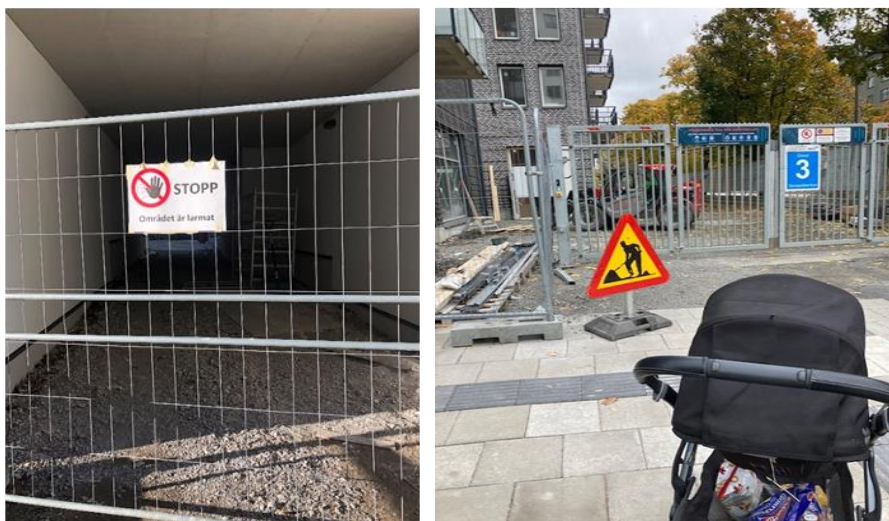
Figur X. Svårt att ta sig fram under byggnationer
